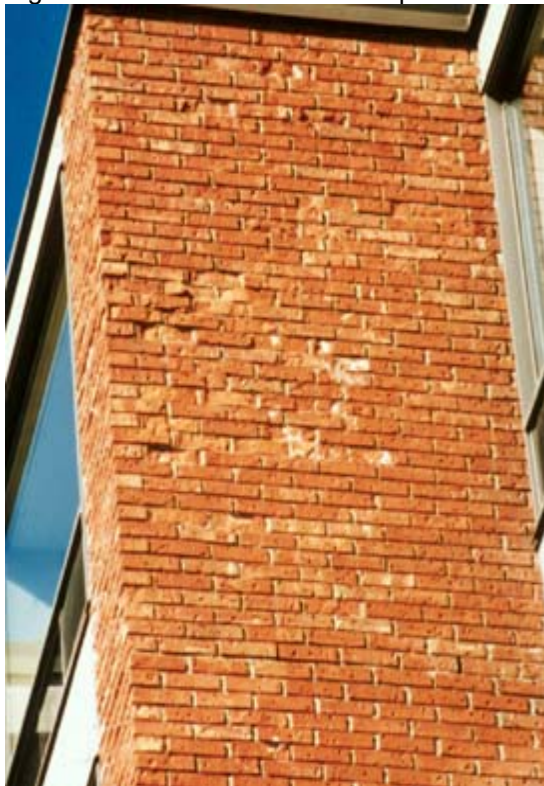
Figure 3 – Effritement de la brique
