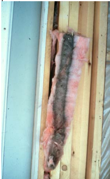
Figure 6 – Mouvement d'air par diffusion
