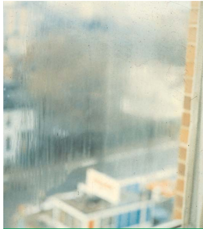
Figure 13 – Vitre isolante embuée par la condensation
