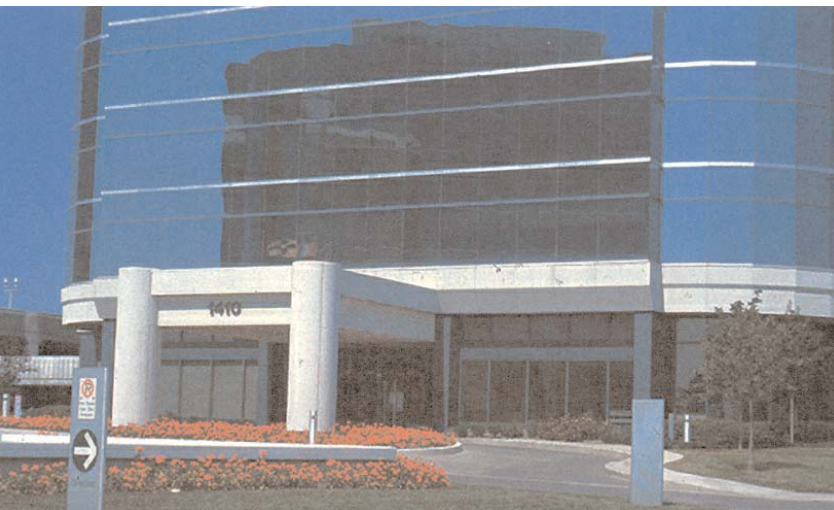
Figure 6 – Système de vitrage structural au silicone
