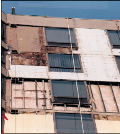
Enlèvement et remplacement du revêtement
