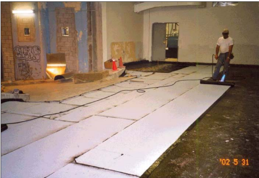
Figure 7. Imperméabilisation de la dalle structurale
