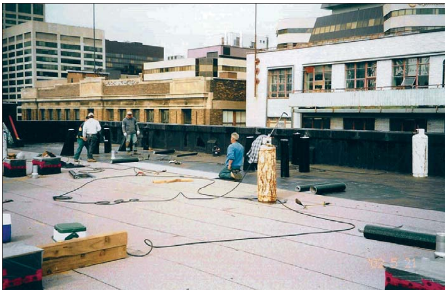
Figure 6. Travaux d'étanchéisation sur le toit principal
