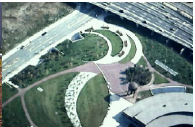
Fig. 6 – Roundhouse park, Toronto, Ontario, Canada Toit vert au niveau du sol
